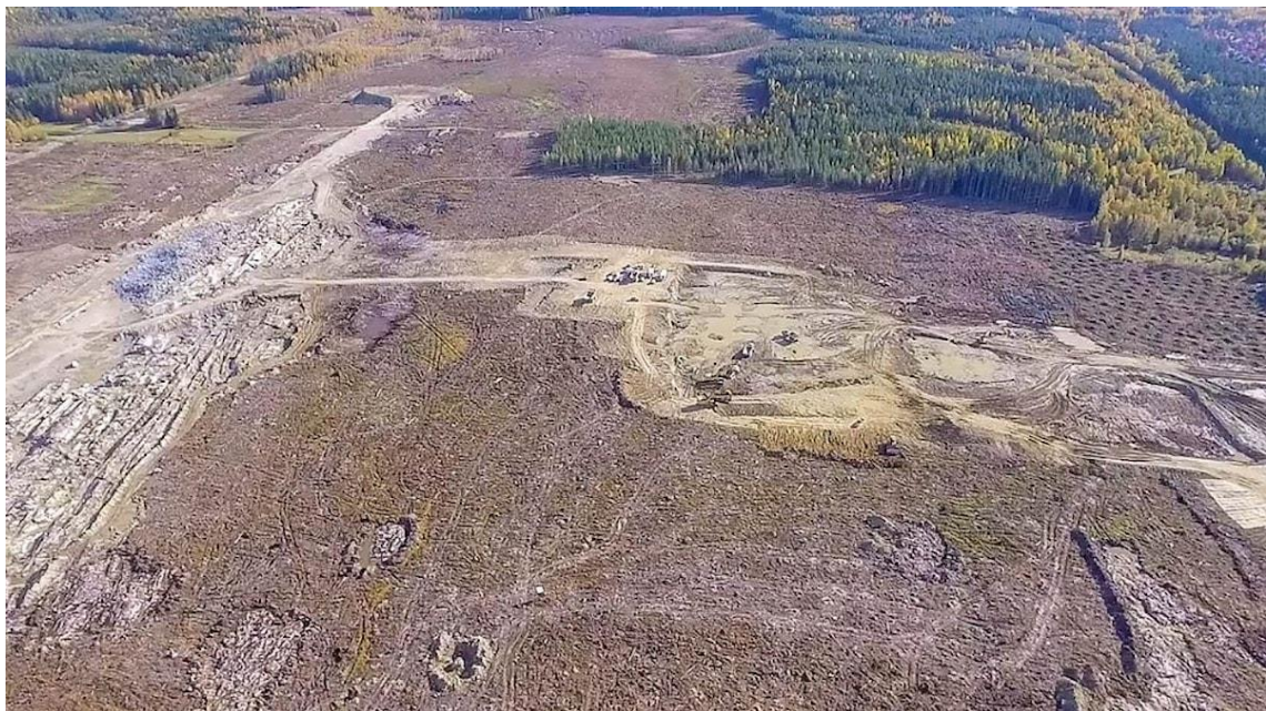
Figur 5.9 Påbörjat schaktarbete för planerad batterifabrik, Skellefteå. Pilotfall 5. ( www.skellefteå.se ).
