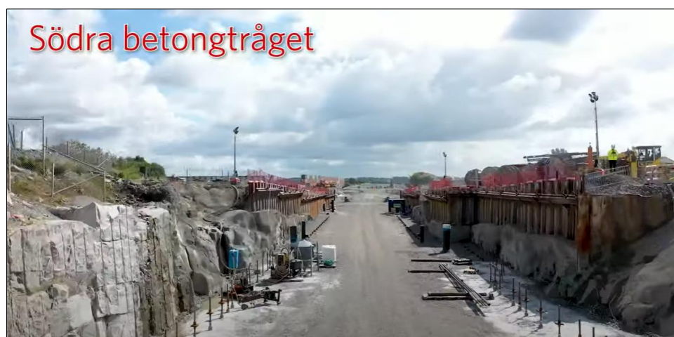
Figur 5.6 Varbergstunneln, södra tunnelpåslaget. Bild tagen strax utanför tunnelmynningen vid schakt för betongtråg.
