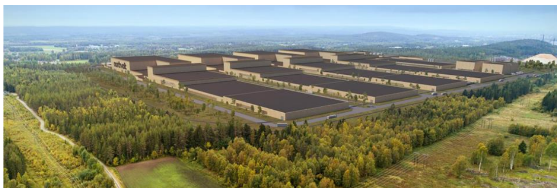
Figur 5.7 Illustration över planerad batterifabrik, Skellefteå. Pilotfall 5. ( www.skellefteå.se ).
